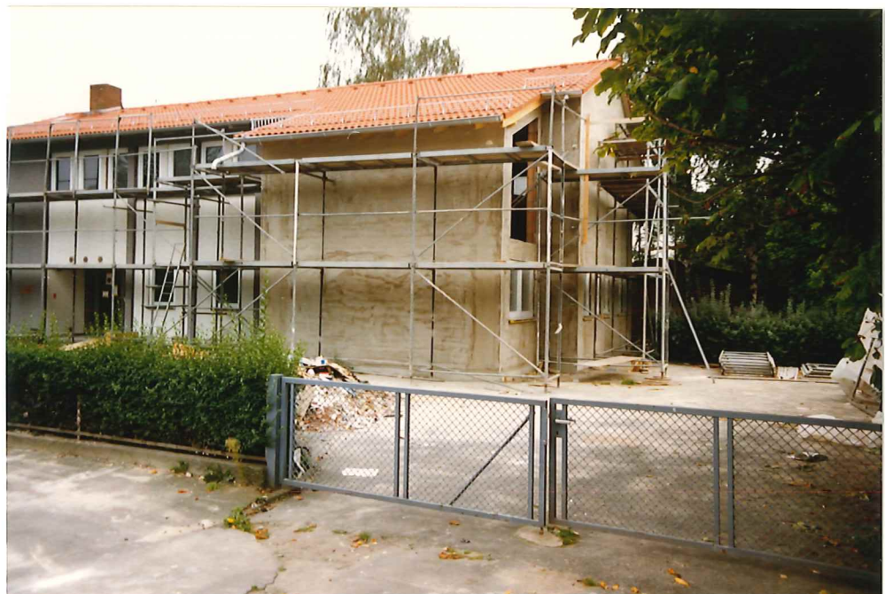
Verlängerung und Anbau sind bereits fertig verputzt
