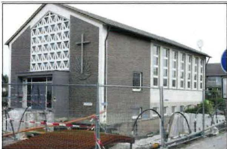
Am Gebäude der Neuapostolischen Kirche in der Barbarossastraße 109 werden derzeit einige bauliche Veränderungen vorgenommen.
