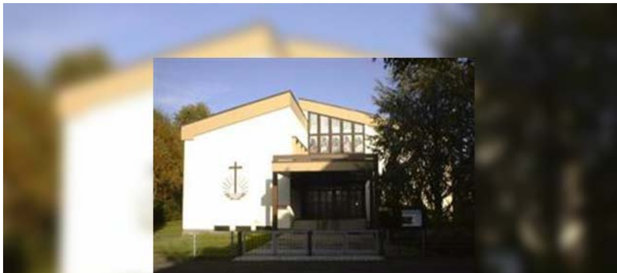
Das heutige Kirchengebäude in Schopfheim
