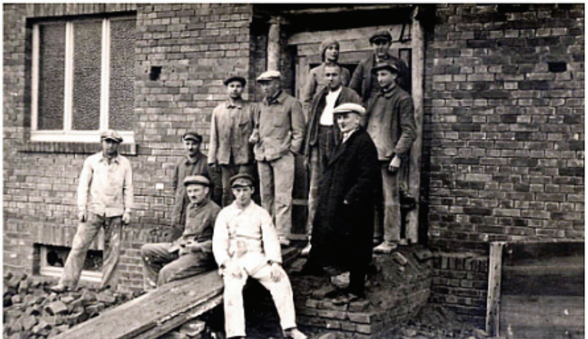
Bei dem Umbau des Umspannwerkes - Anfang der dreißiger Jahre - in der Willibracht- straße halfen viele Geschwister mit
