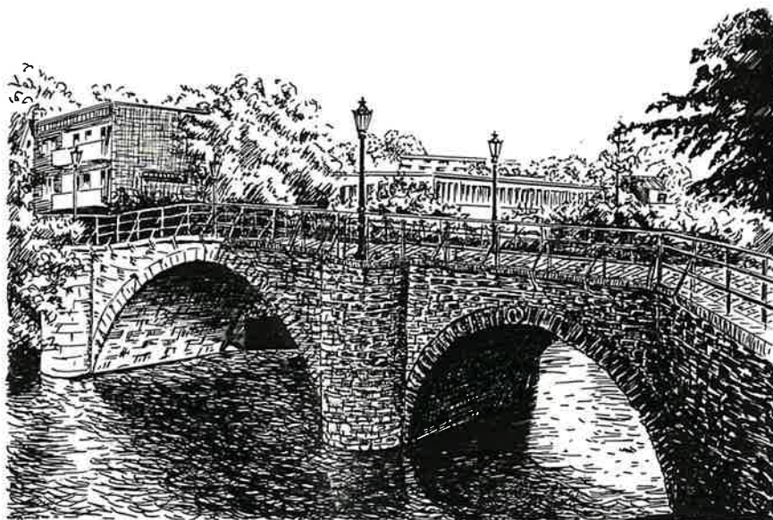
Alte Beckinghauser Brücke
