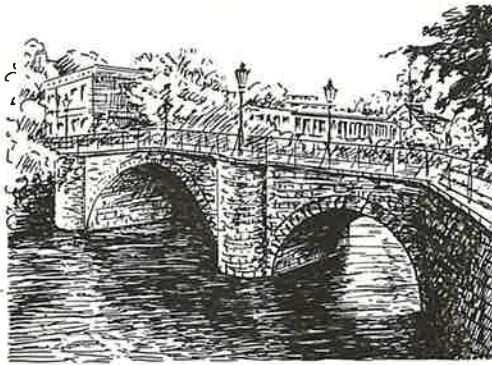
Alte Beckinghauser Brücke
