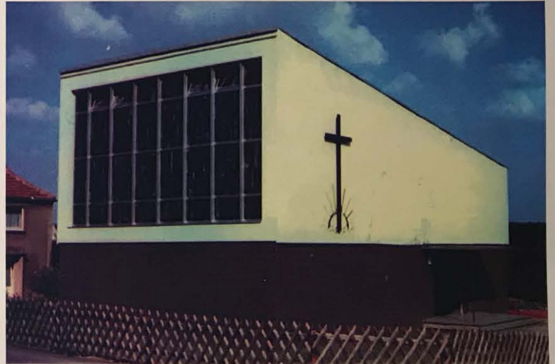
Das neu errichtete Gotteshaus in der Hildegundestrasse
