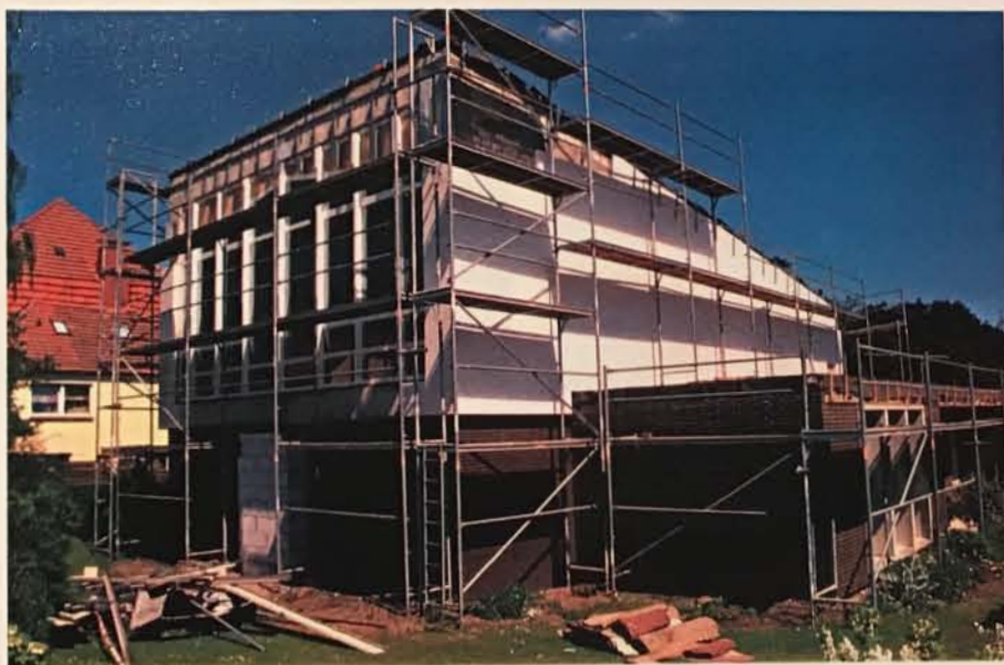
unser Kirchlein wird im Jahr 2000 renoviert und saniert
