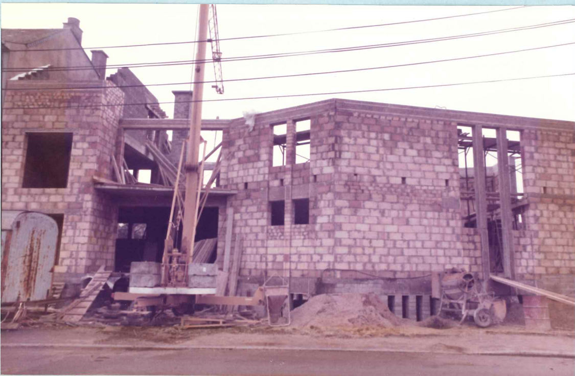
Die neue Kirche im Rohbau - Bildaufnahme vom 24.11.1984
