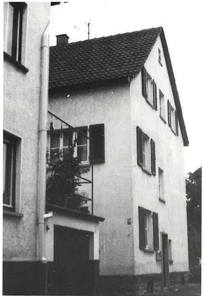
Haus Dammstraße 46/1 in Heilbronn. Hier fanden bei den Brüdern Mezger und Csechitzky im Dachgeschoß die ersten Zusammenkünfte statt (1901)
