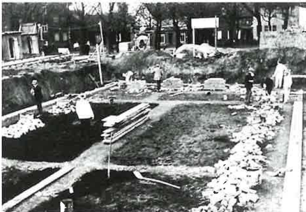
Während der Bauarbeiten -1955
