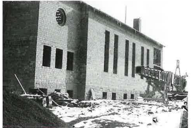
Während der Bauarbeiten -1955
