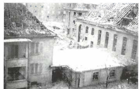
Die zerstörte Kirche in der Händelstraße
