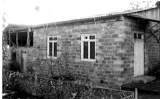
... sowie Saal, der zur Versammlungsstätte umgebaut wird
