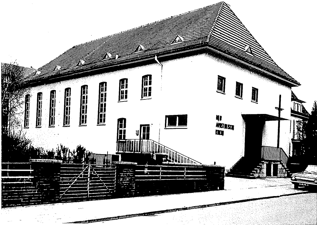
Die Kirche in Gießen-Süd, Händelstr. 1, nach dem Umbau
