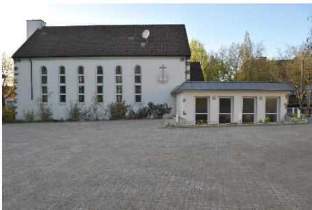
Blick vom Parkplatz auf den fertigen Anbau
