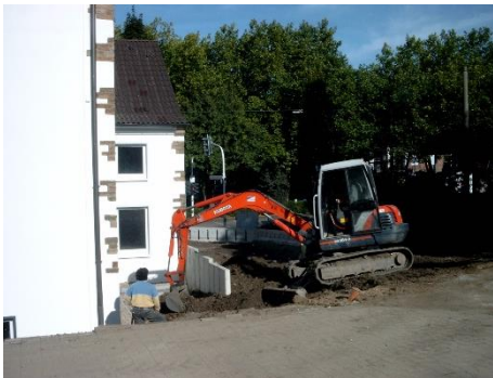
Baggerarbeiten im Außenbereich, hier im Zuge der rückseitigen Türversiegelung
