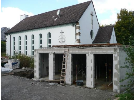
Blick auf den Anbau
