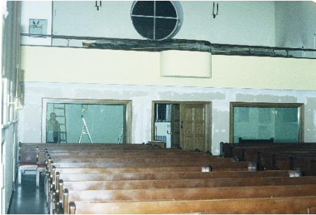
Blick vom Kirchenschiff auf die eingezogene Rigipswand, Eltern-Kind-Raum (r.)
