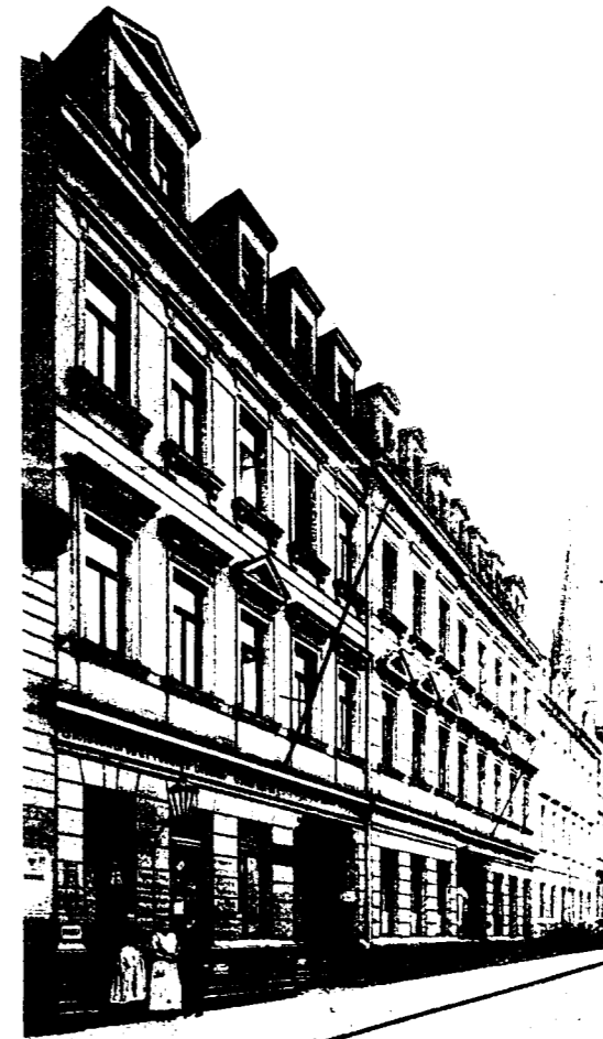
Neuapostolische Kirche in Dresden. Vorderhaus, 13 Fenster Front.
