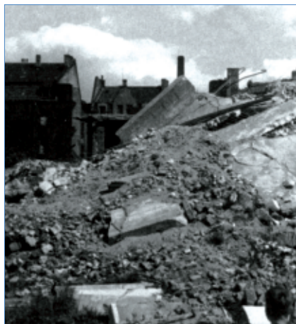
Die Kirche liegt in Trümmern
