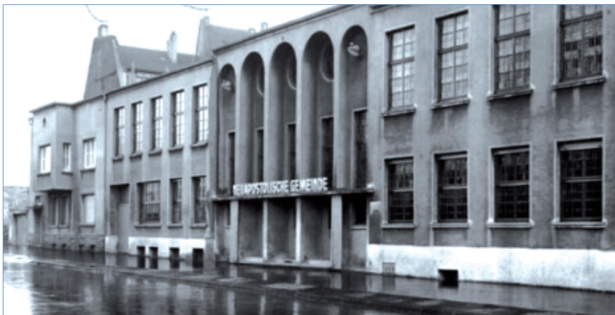
Braunschweiger Straße: die neu errichteten Gebäude
